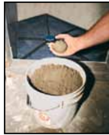
Llénelo con mezcla de cemento y arena
